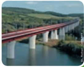
1 Franchissement des cours d'eau
