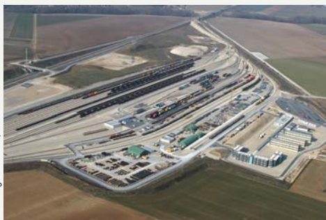
// La base travaux de Vadenay sur la LGV Est européenne, avant son démantèlement.
